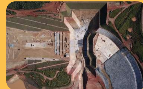
Visão geral da obra. Data: 14/05/22
