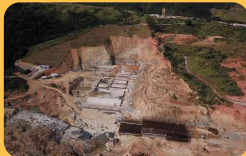
Visão geral da obra. Data: 14/05/22
