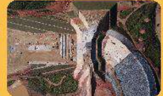
Visão geral da obra. Data: 14/05/22
