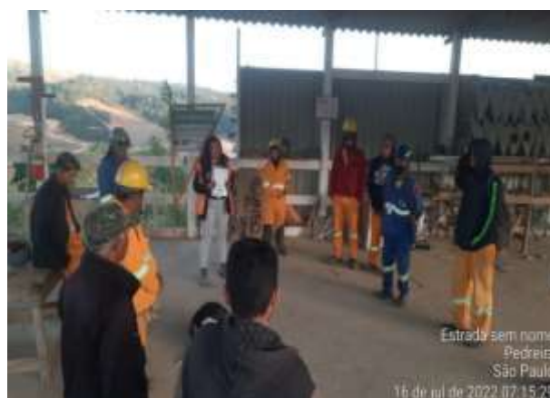
Foto 8 – Treinamento sobre Uso Sustentável, realizado com equipe na frente de serviço da Carpintaria. Data: (16/07/2022).
